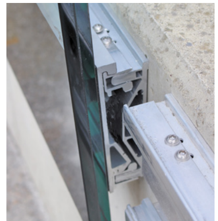
Profilschnitt mit Glas und Verschraubung
